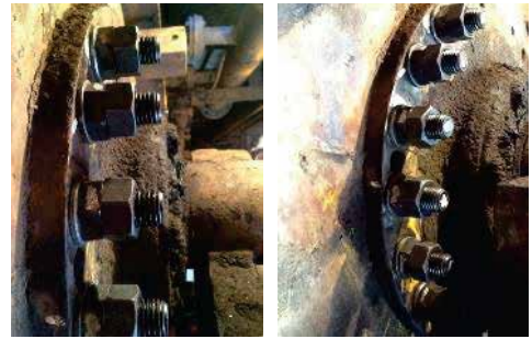
설치된 하드록 너트
